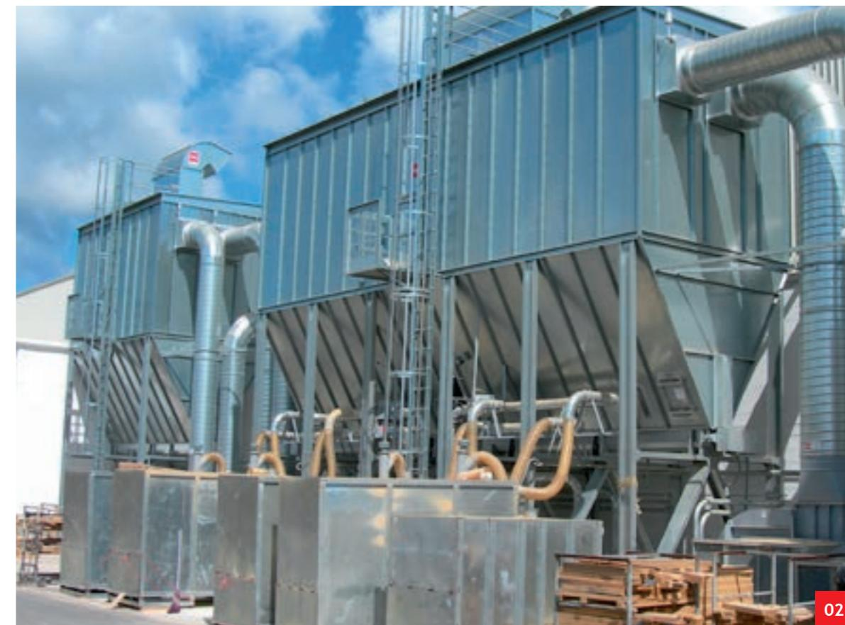
**02.** Sottostazioni con più linee di aspirazione e valvole di non ritorno. Il travaso delle polveri avviene in box metallici
