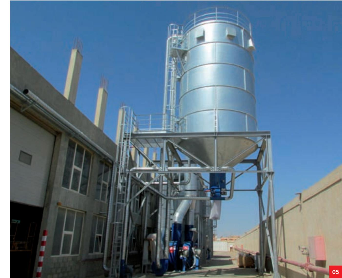
**01.** Silo zincato a caldo partenza da terra con doppio scarico polveri: - per alimentazione caldaia - con coclea laterale per scarico su camion
