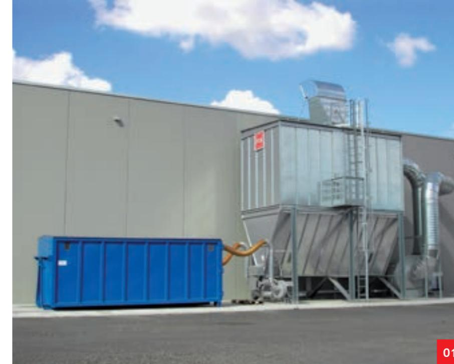
**01.** Sottostazione con sistema di trasporto pneumatico delle polveri in cassone scarrabile
