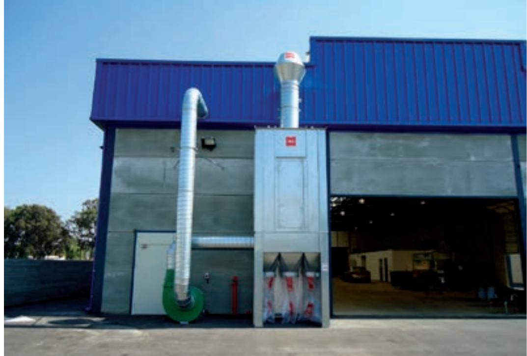
Sottostazioni filtranti con scarico in continuo
