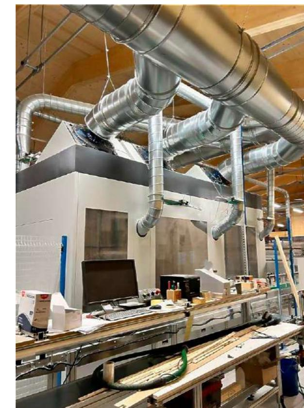
**Apparecchiature per il rilevamento e spegnimento automatico delle scintille****Automatic sparks detection and extinction system**
