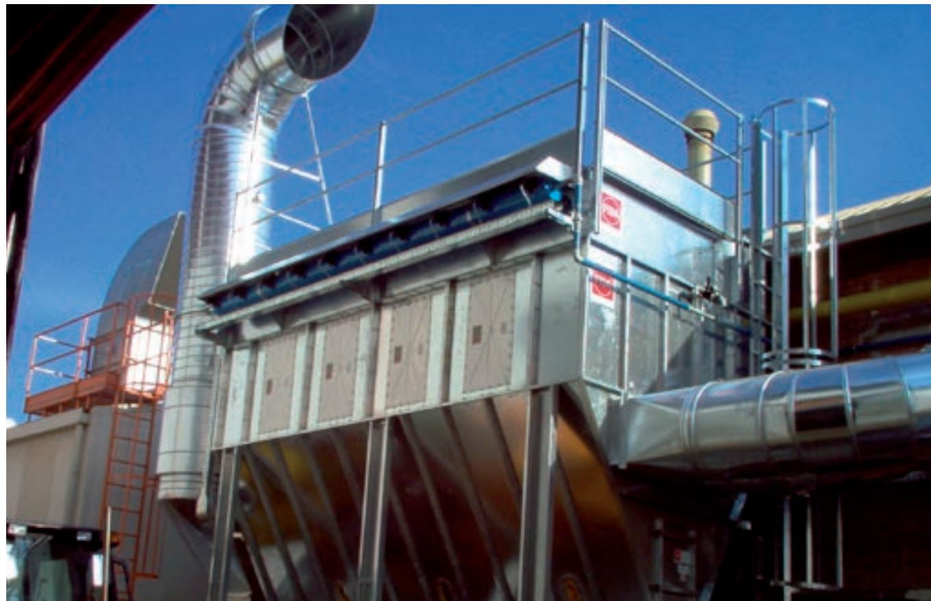
Filtro a maniche a pulizia automatica in controcorrente con ventilatore di soffiaggio.
