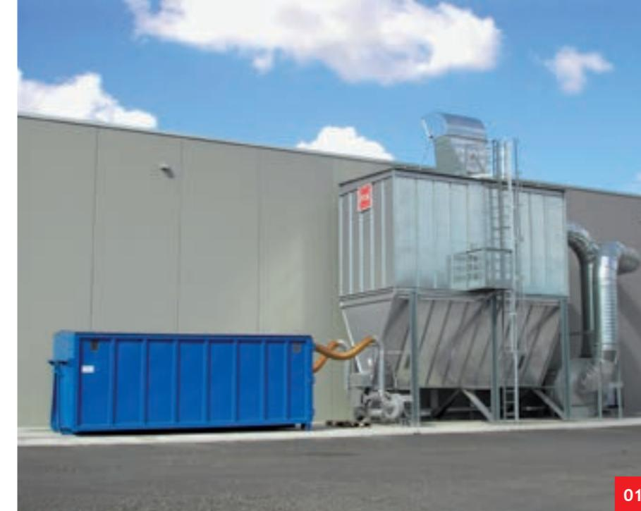
**01.** Sottostazione con sistema di trasporto pneumatico delle polveri in cassone scarrabile
