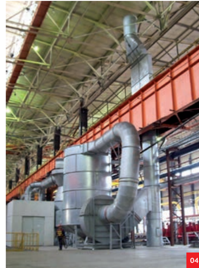
04. Impianto di abbattimento fumi di laminatoio completo di canalizzazione, scrubber, ventilatore e camino. System for rolling mill exhaust fumes complete with piping, wet scrubber, fan and chimney Оборудование очистки дымов для прокатного стана, укомплектованное трубопроводами, газоочистителем, вентилятором и дымоходом
