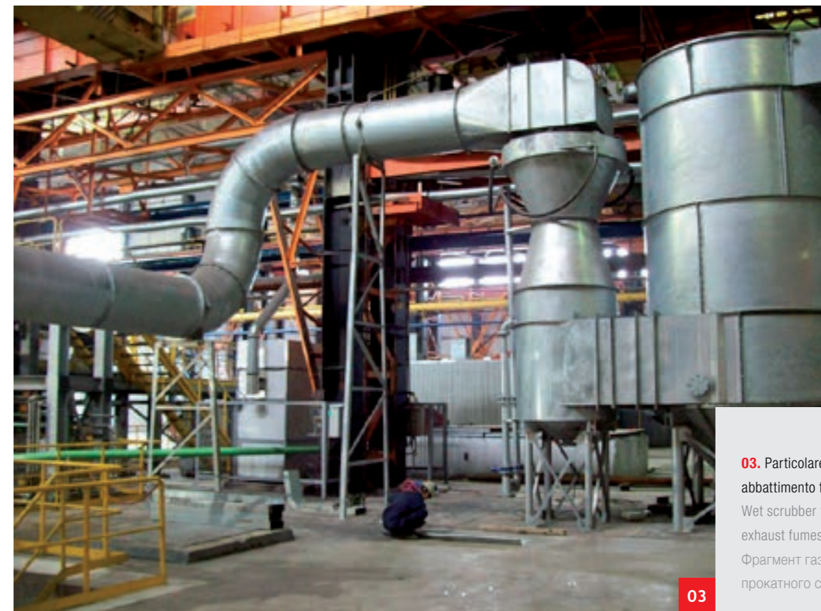
04. Impianto di abbattimento fumi di laminatoio completo di canalizzazione, scrubber, ventilatore e camino. System for rolling mill exhaust fumes complete with piping, wet scrubber, fan and chimney Оборудование очистки дымов для прокатного стана, укомплектованное трубопроводами, газоочистителем, вентилятором и дымоходом
