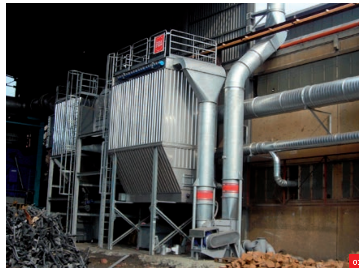
02. 03. Scambiatore di calore e filtro a pulizia automatica in controcorrente. Impianti coibentati Heat exchanger and self-cleaning filter. Both machines are insulated Теплообменник и фильтр с автоматической очисткой противотоком. Изолированное оборудование
