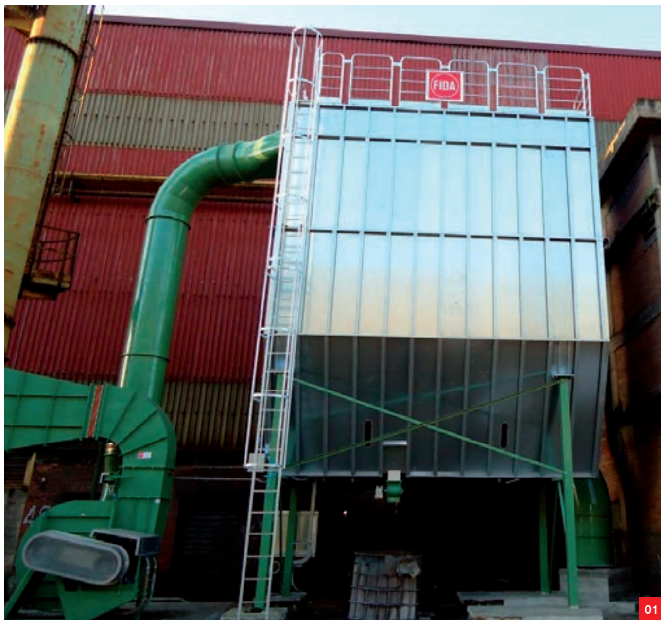
01. Filtro a pulizia automatica in controcorrente per abbattimento polveri di molatura barre di acciaio Self-cleaning bag filter with pneumatic reverse air bags cleaning system for dusts coming from steel bars grinding process Фильтр с автоматической очисткой противотоком воздуха для пылеулавливания при шлифовке стальных прутков
